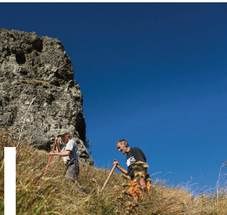
Au pied du rocher du Bec de l'Aigle, les travées, comme des rigoles creusées par les passages des randonneurs et le ruissellement de l'eau, sont restaurées avec de la toile de coco. À certains endroits, des marches sont construites, pour structurer le sentier, ainsi que des passages pour l'écoulement de l'eau. PHOTOS JÉRÉMIE FULLERINGER
