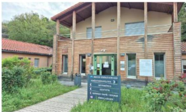
La maison de santé de Massiac : le chantier devrait débuter dans les prochaines semaines.
