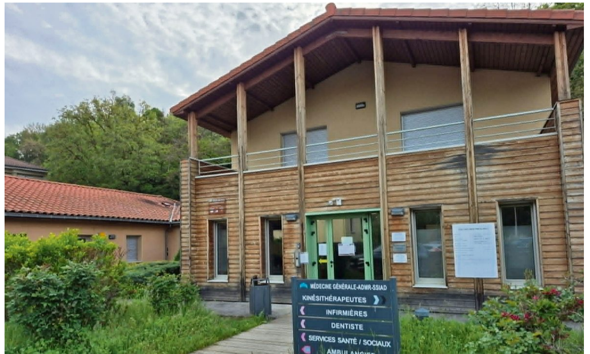
Les travaux de réaménagement et d'extension de la maison de santé de Massiac débuteront dans le courant de l'année. Ils permettront de rendre accessible l'étage du bâtiment pour disposer de trois bureaux professionnels, d'accroître la surface du plateau technique du kiné et de réagencer et rénover les espaces.
