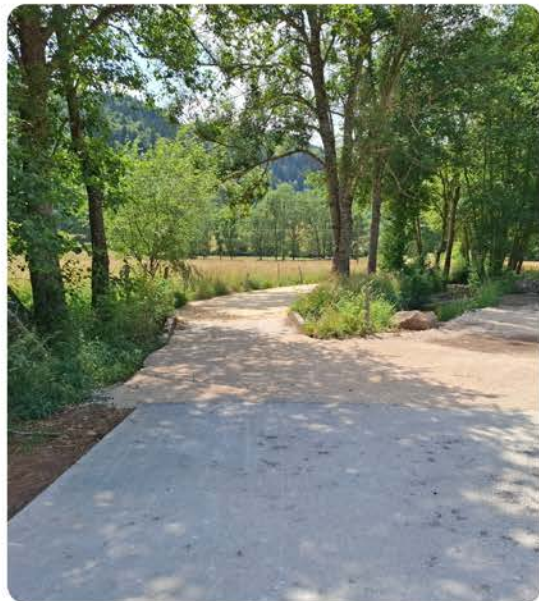
Laveissière-Chambeuil : Reprise du chemin et aménagement d'une dalle béton pour favoriser la circulation de l'eau lors des périodes d'inondations
