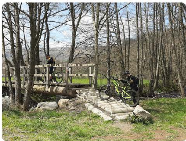
Laveissière-Chambeuil : Epaulement de la passerelle et installation d'une marche en bois pour permettre un passage en vélo
