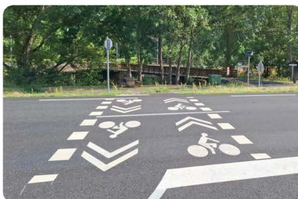
Un marquage de la voirie RN122 pour canaliser la traversée
