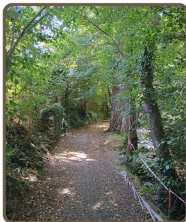
Mélange terre/pierre 1,5 km
