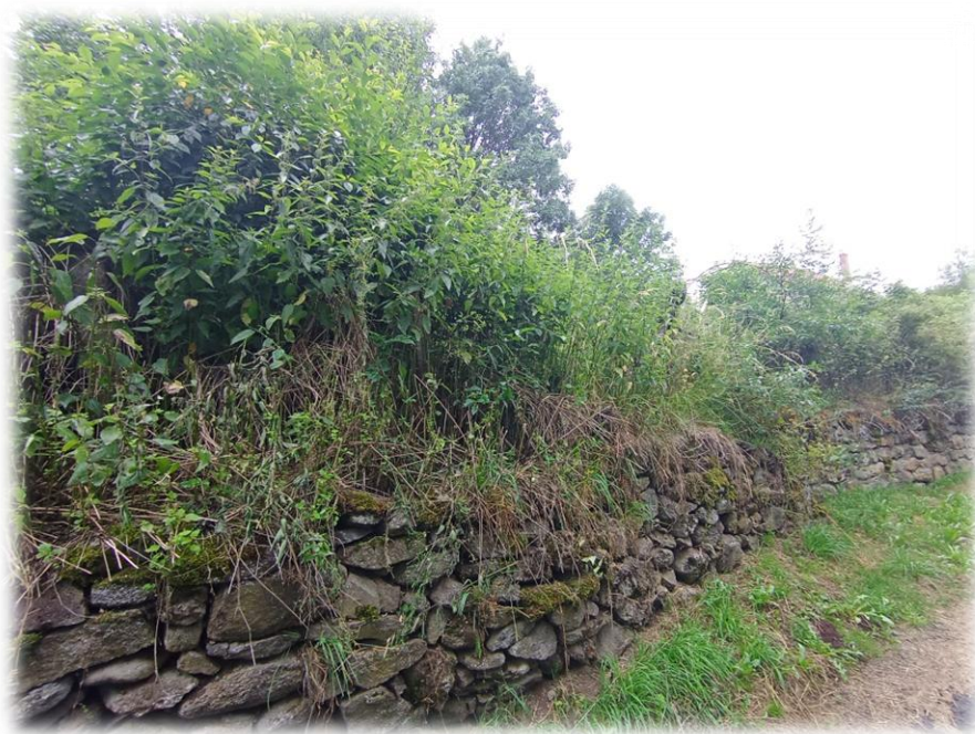
Exemple de muret en pierre sur la commune de Sainte-Anastasie
