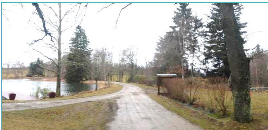
Allée stabilisée desservant l'étang et la maison existante ©CAMPUS
