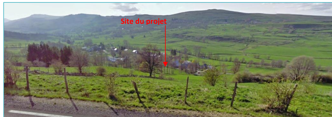
Vue sur le site depuis la RD3 ©Google Street View
