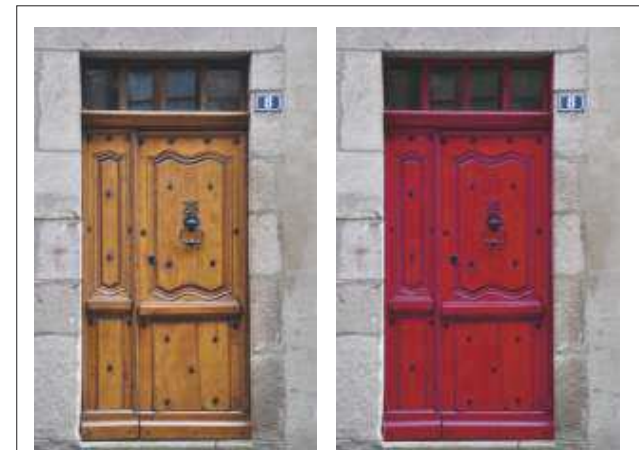
Les portes anciennes peuvent être traitées soit en teinte bois, soit en brun-rouge plus ou moins soutenu.
