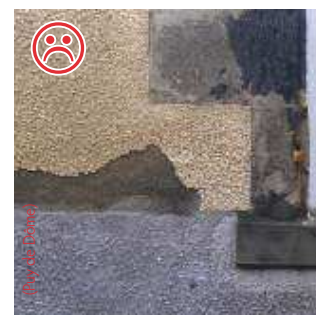
De très nombreux joints à base de ciment ont été réalisés autour des années 1900. Outre leur aspect inesthétique, ils peuvent amener des dégradations des maçonneries. (Tous les exemples dans le Cantal)
