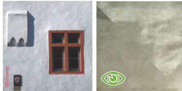
Les supports les plus anciens sont parfois très irréguliers. L'enduit doit suivre ces irrégularités, sans chercher ni à les masquer, ni à les accentuer.
