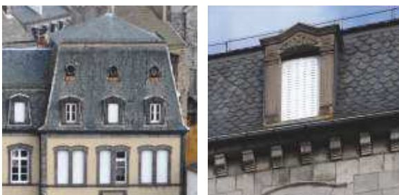
Les terrassons en faible pente, peu visibles de la rue, pourront être refaits en zinc. (Raccord brisis-terrasson en bande de métal)
