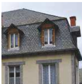
Les terrassons en pente moyenne, visibles depuis l'espace public seront refaits en ardoise. (Raccord brisis-terrasson en ardoise)
