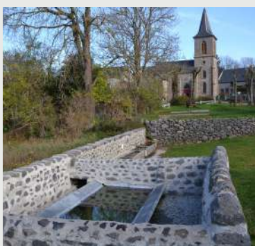
Rénovation du Petit patrimoine (1.2 M€) et Burons (1.6 M€)
