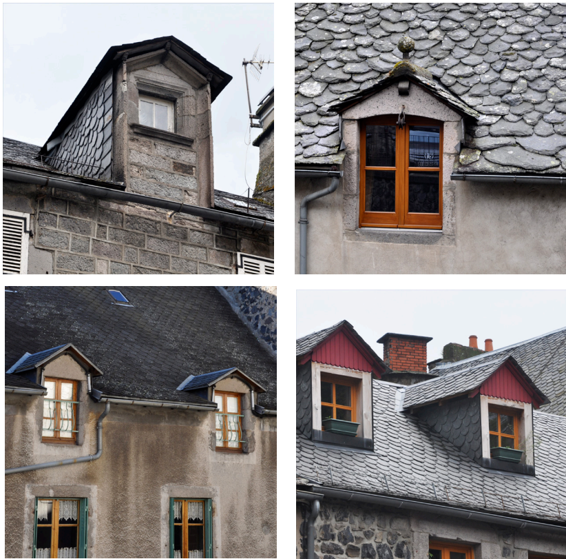
À Murat le modèle de lucarne à fronton triangulaire en prolongement de la façade est assez répandu, depuis les période anciennes jusqu'au XIXe siècle: il est destiné à rendre habitable le comble. Mais d'autres modèles existent.
