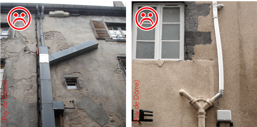
Aucune canalisation extérieure ne devra être apposée sur les façades, à l'exception des eaux pluviales qui devront être positionnées aux extrémités des façades.
