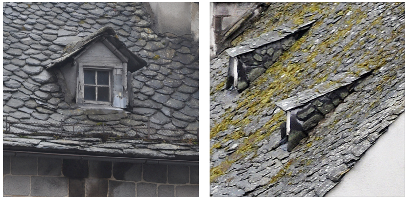
Il existe également, pour éclairer des combles non habités, de petites lucarnes, ou des outeaux couverts de grandes lauzes (ou ardoises). Ces outeaux ne doivent pas être confondus avec les lucarnes rampantes, procédé moderne à ne pas développer. (clichés pris à Murat)
