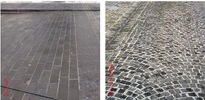
Dans les pays de lave, on met de plus en plus souvent en œuvre des matériaux traditionnels, de manière plus ou moins modernisée. Il est à noter que des carrières existent dans le Cantal (le site de droite a été pavé avec un matériau cantalien).
