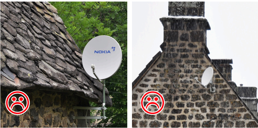
Il est presque toujours possible de disposer les paraboles en superstructure, en général sur les souches de cheminée, ici très massives. Il importe de ne pas encombrer les façades en les apposant sur des balcons ou les parois...
