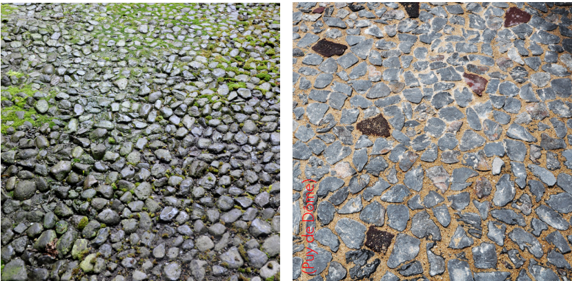
Les sols de galets de Murat n'ont subsisté qu'en de rares endroits (cours privées, passages...). Il est aujourd'hui possible de retrouver cet aspect, par mise en œuvre de galets fendus, au rendu plus confortable.
