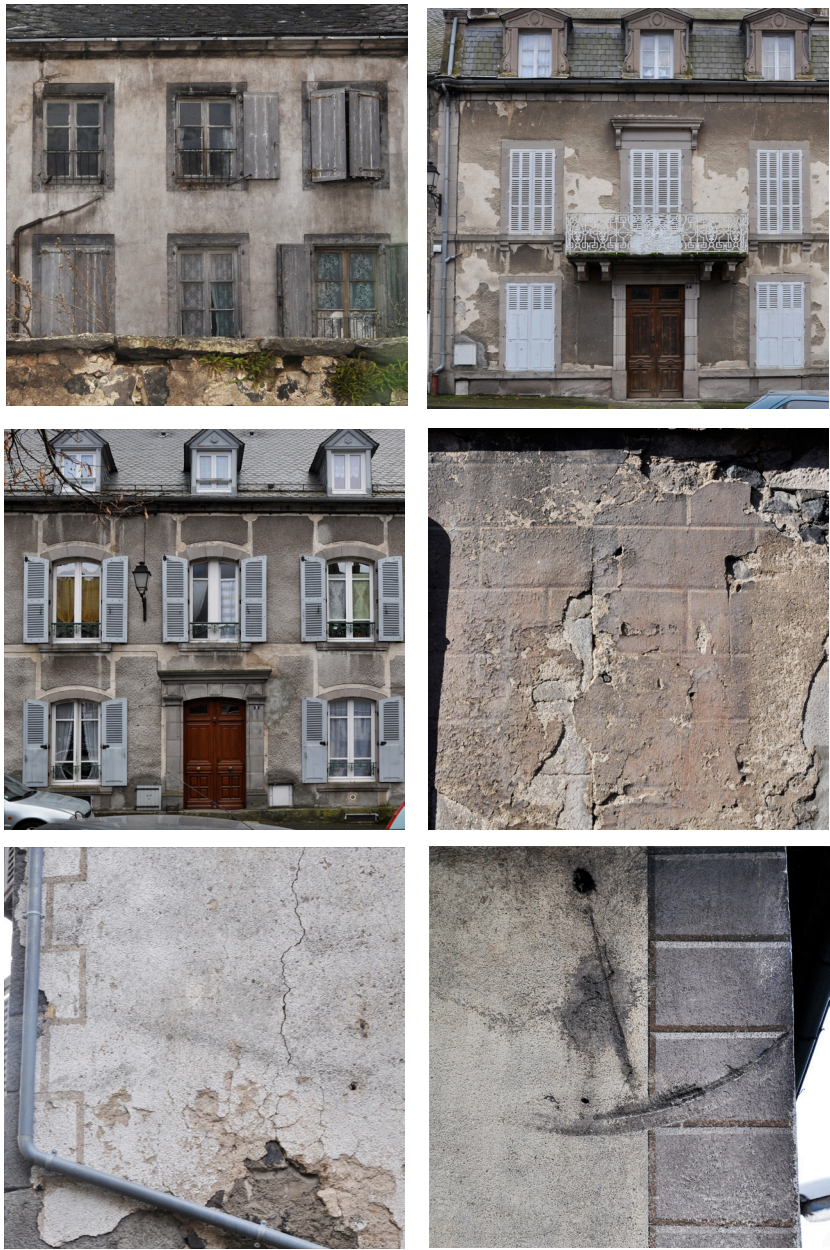
Des périodes anciennes jusqu'aux années 1900-1920, on met en œuvre des maçonneries enduites, dont des échantillons nous sont parvenus. Teinte, grain et texture de l'enduit , éventuels décors (parfois simples, parfois sophistiqués...) varient en fonction des époques et des typologies. Ces dispositifs sont à maintenir, et peuvent servir d'exemples à reproduire.
