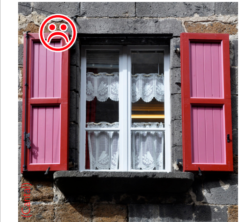
Il est également important que les volets et les fenêtres soient traités de la même manière... et dans des teintes unies.
