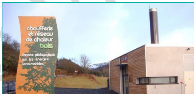
Chaufferie collective bois de Murat ©Hautes Terres Communauté
