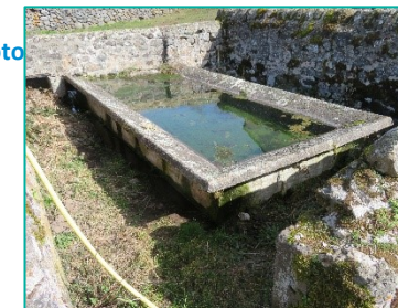
Lavoir, Recoules, Joursac
