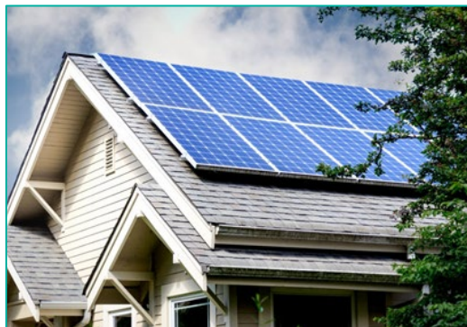
Panneaux photovoltaïques en surimposition ©EDF
