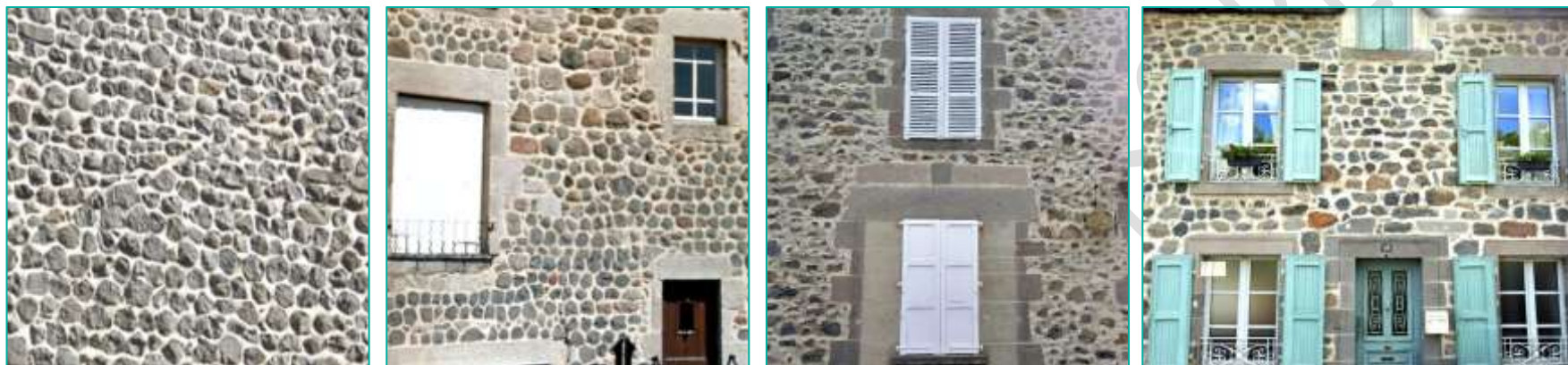
Différents styles de pierres à joint de mortier à Murat - web
