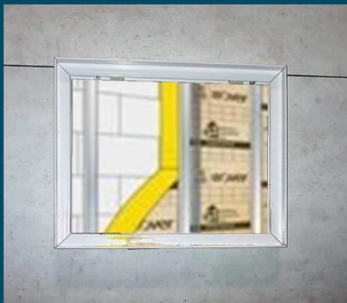
Des **écorchés** dans les parois permettant de découvrir les technologies d'**isolation** des murs et plafonds
