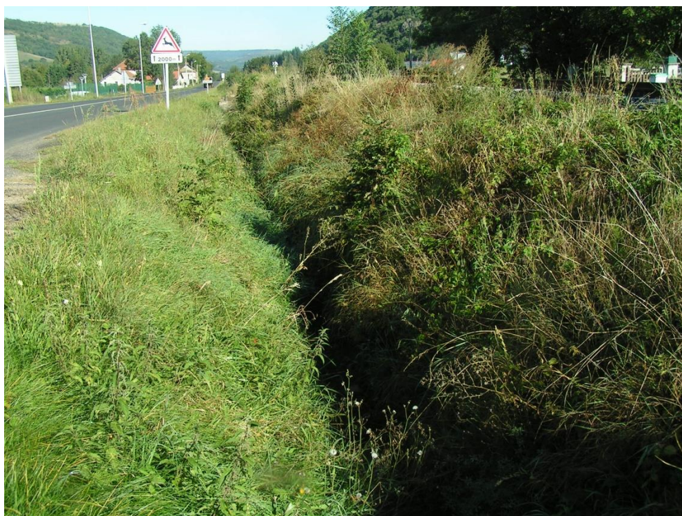
Photographie 4 : Fossé de la D 909
