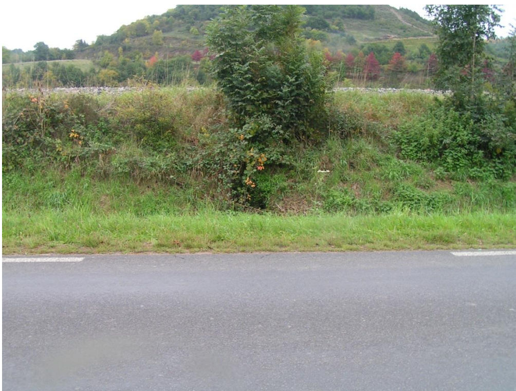
Photographie 3 : conduite EP passant sous la voie de chemin de fer
