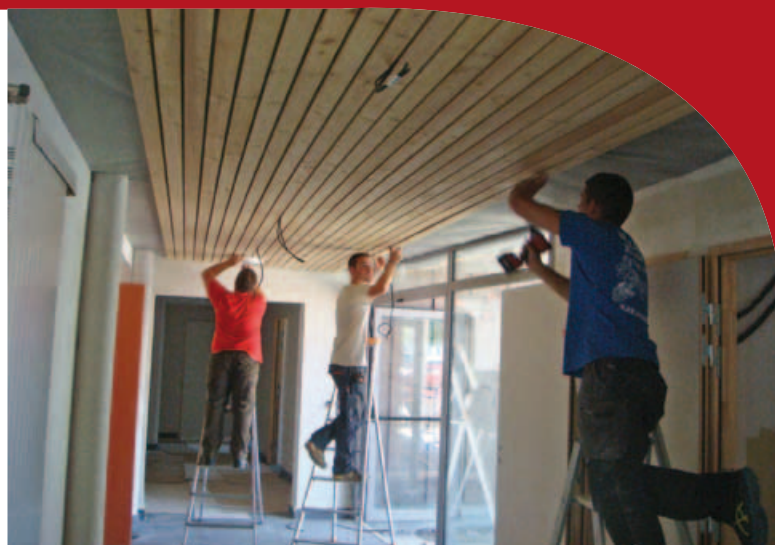
Travaux d'isolation pour améliorer les performances énergétiques de nos bâtiments publics.
